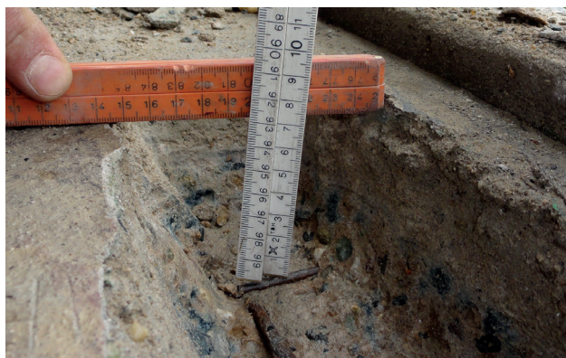
Figuur 3-3 Verificatie wapening vanaf bovenzijde galerijvloer.
