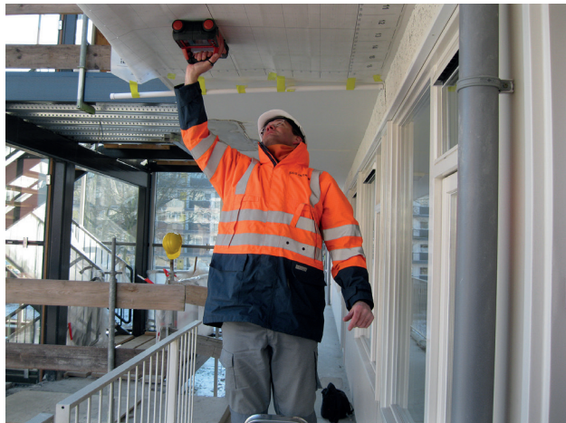
Figuur 3-2 Radarmeting aan onderzijde galerijvloer.
